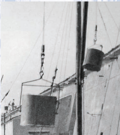
Baja – merilna posoda za prenos soli v skladišča skozi streho
